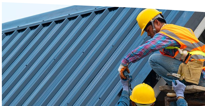
ALMACEN MTC -COBERTURAS DE TECHOS Y CERRAMIENTOS LATERALES.
