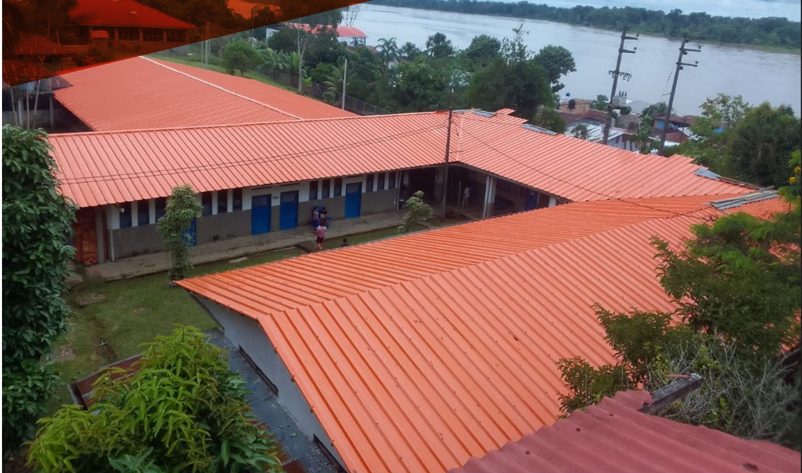
HOSPITAL SANTA CLOTILDE - IQUITOS -COBERTURAS DE TECHOS Y CERRAMIENTOS LATERALES. -PANEL TP4 - ALUZINC GRANATE.
